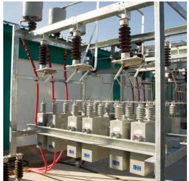
Kapasitör bank kurulum şekli Capacitor bank application
